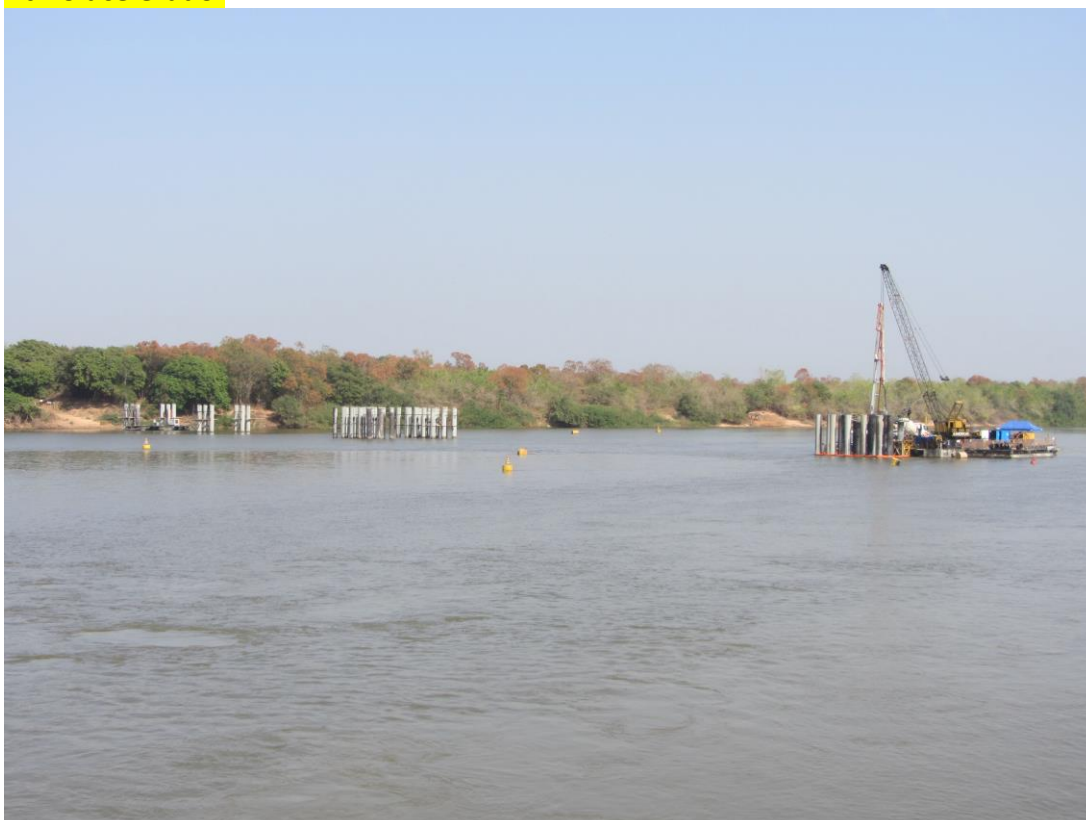
Obra da ponte do Rio Araguaia – BR 080 – agosto 2021
